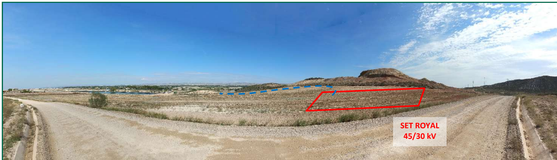
Fotografía 2. Ubicación SET Royal 45/30kV.
