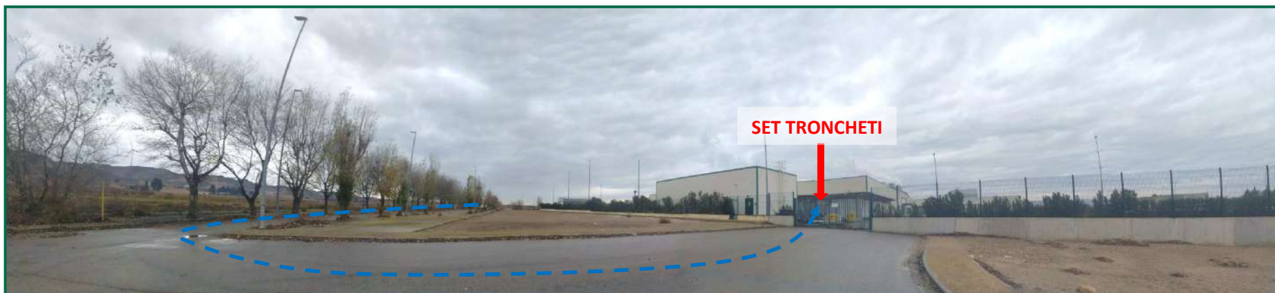
Fotografía 17. Tramo final de la línea de evacuación, llegada a SET Tronchetti.
