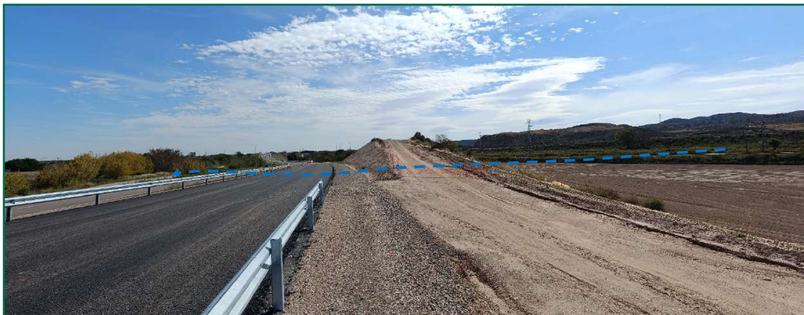
Fotografía 7. Recorrido de la línea de evacuación soterrada, cruce ramal de la carretera.
