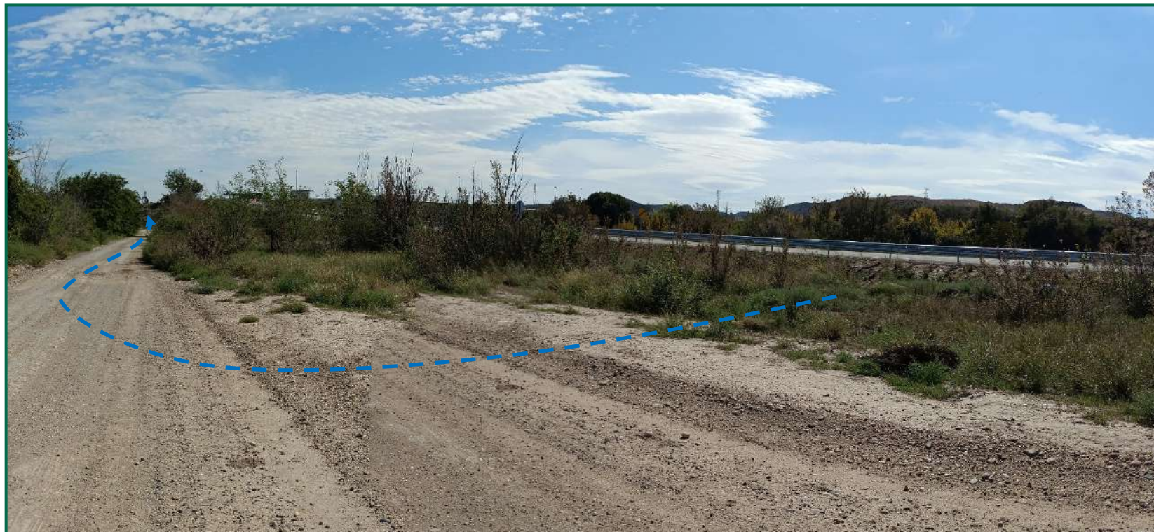
Fotografía 8. Recorrido de la línea de evacuación soterrada
