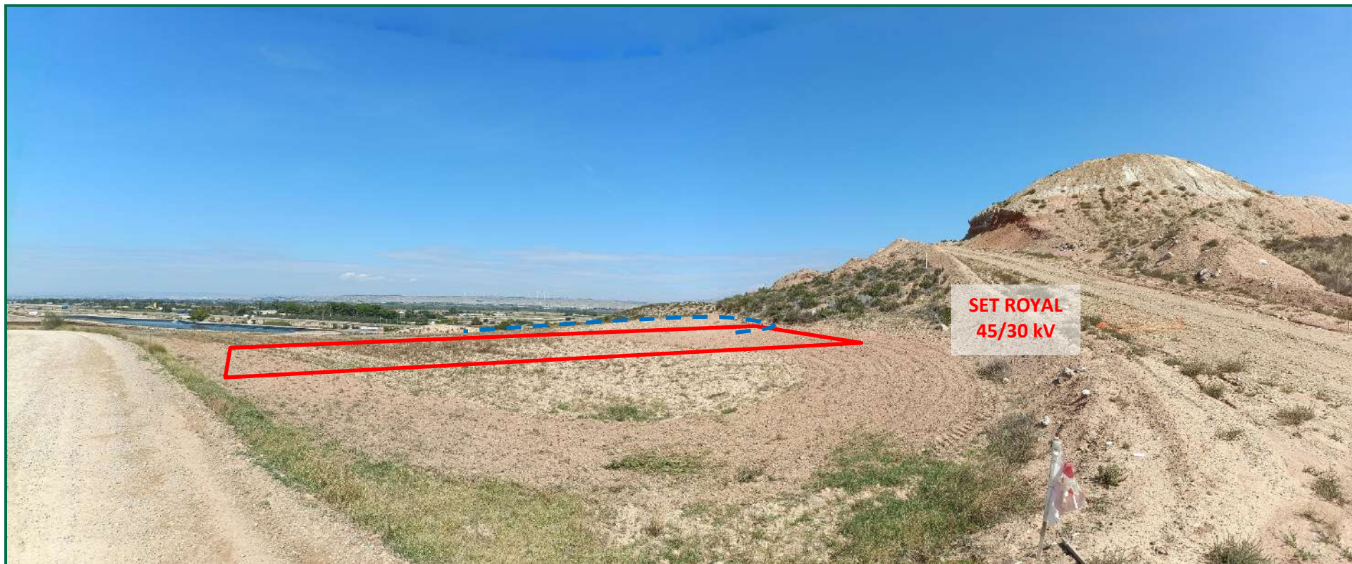
Fotografía 3. Ubicación SET Royal 45/30kV.
