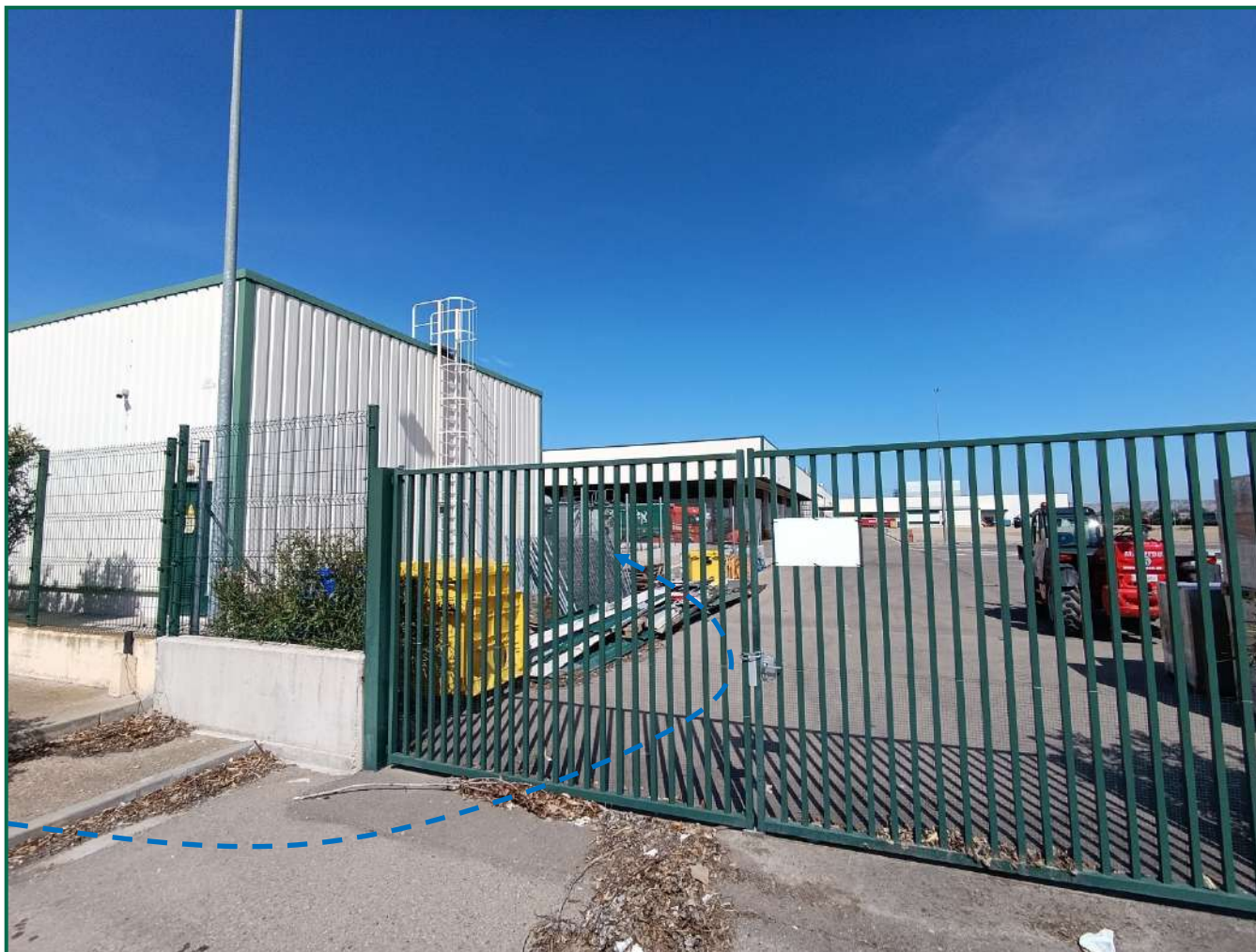
Fotografía 16. Tramo final de la línea de evacuación, llegada a SET Tronchetti.
