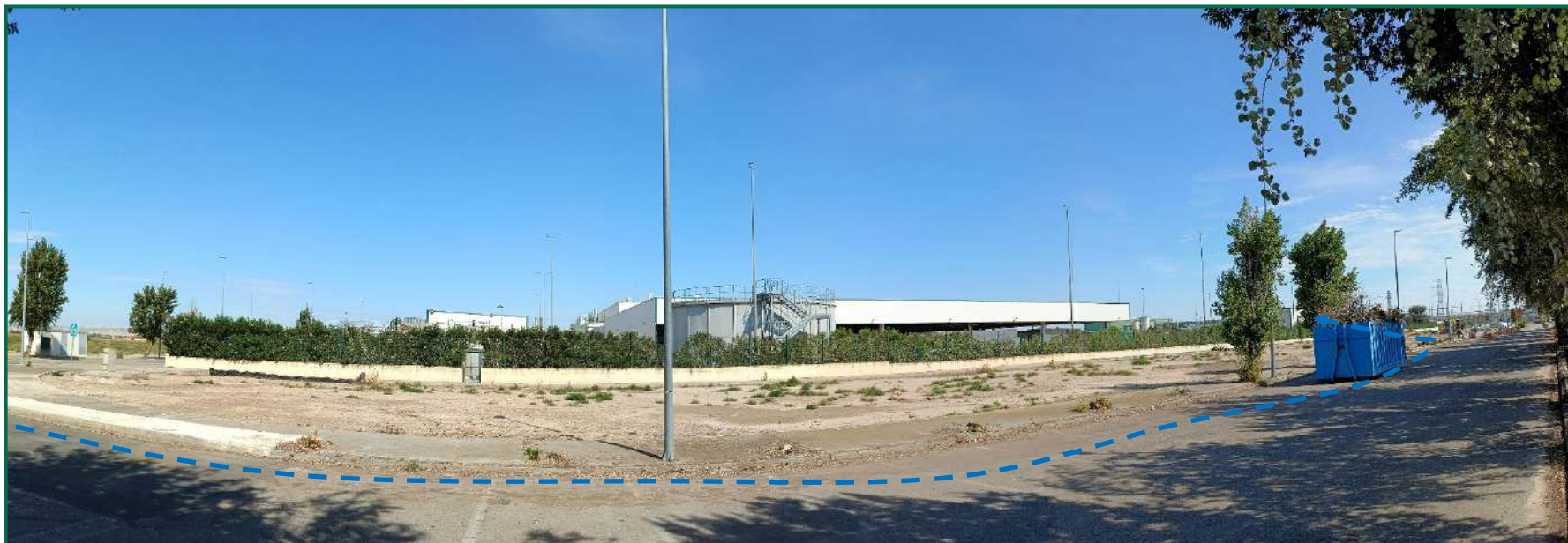
Fotografía 15. Tramo final de la línea de evacuación, llegada a SET Tronchetti.
