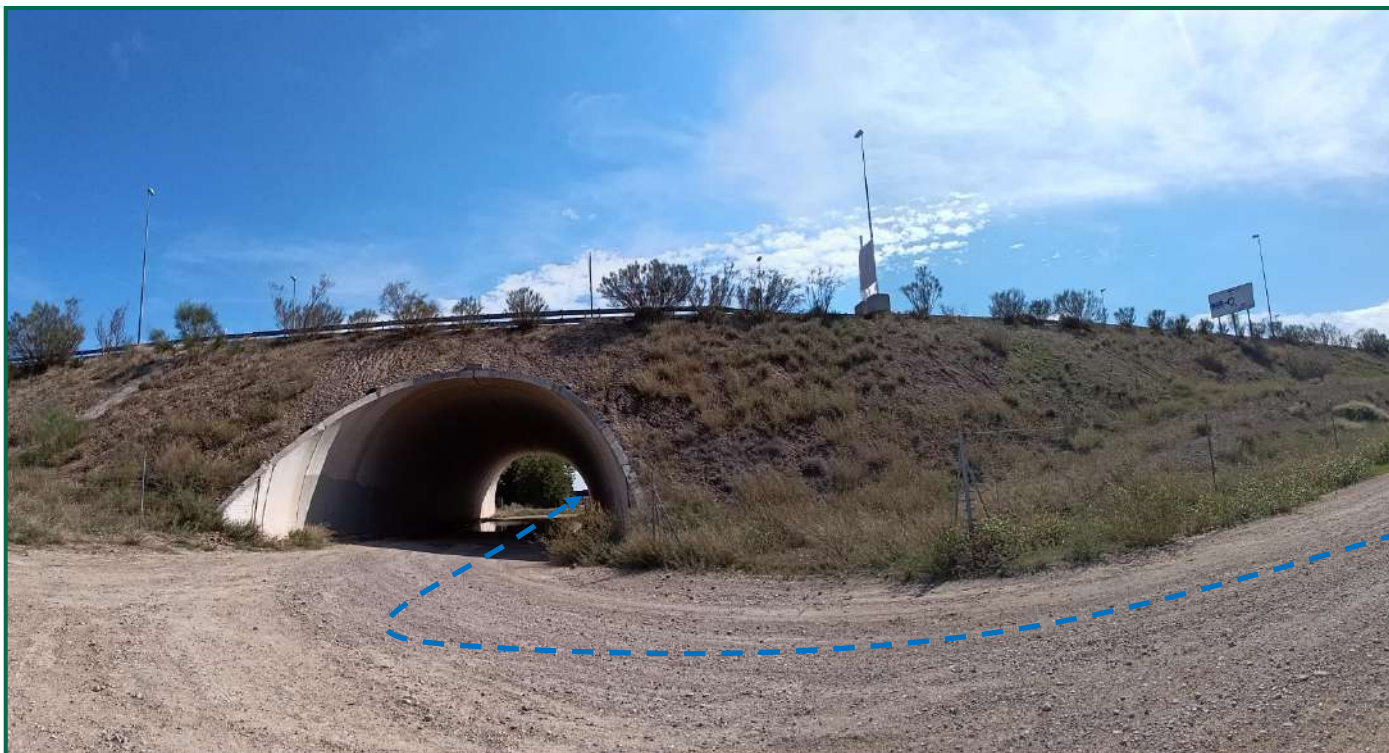
Fotografía 9. Recorrido de la línea de evacuación soterrada.
