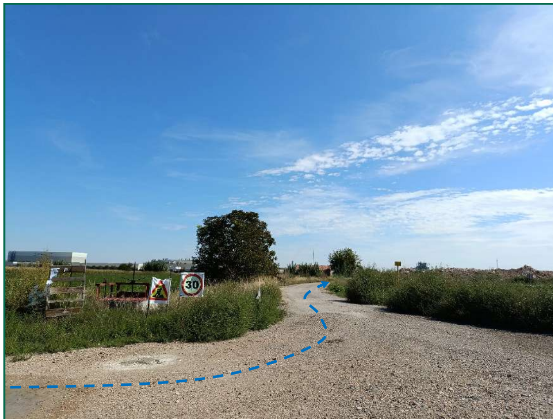
Fotografía 11. Recorrido de la línea de evacuación soterrada
