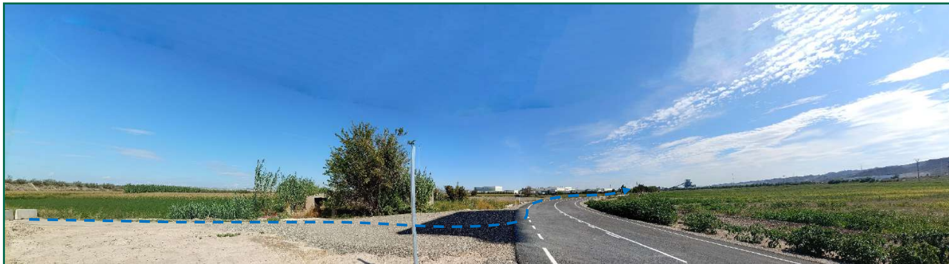
Fotografía 13. Recorrido de la línea de evacuación soterrada
