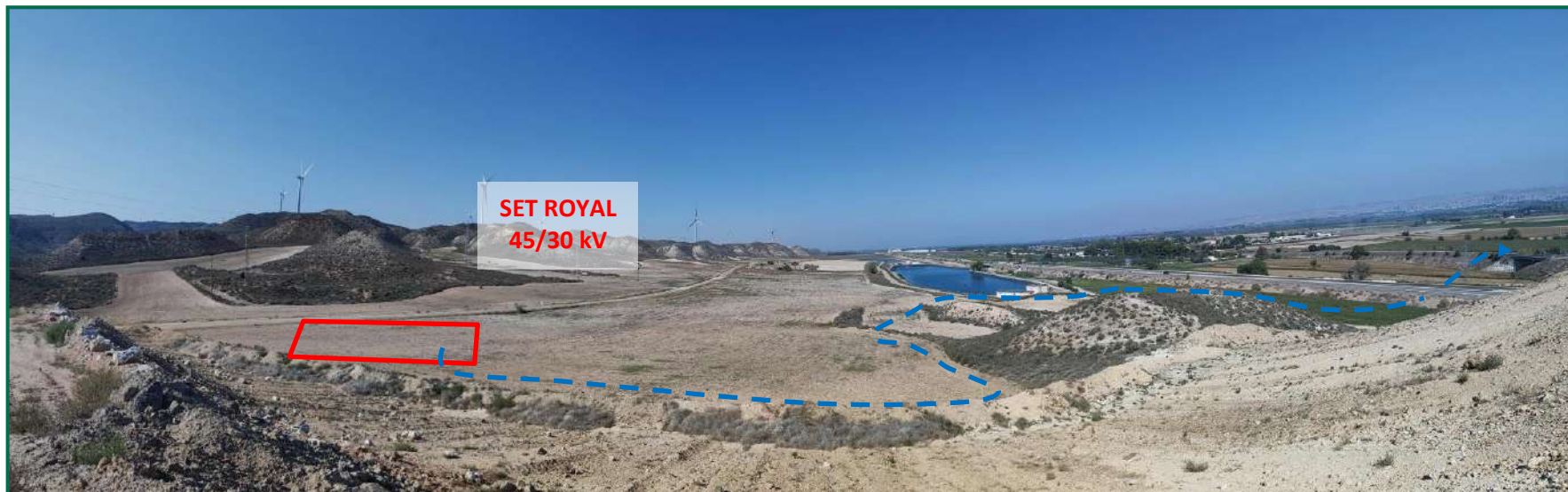
Fotografía 1. SET Royal 45/30kV y comienzo de de la línea de evacuación soterrada hacia SET Tronchetti cruzando carretera N232.
