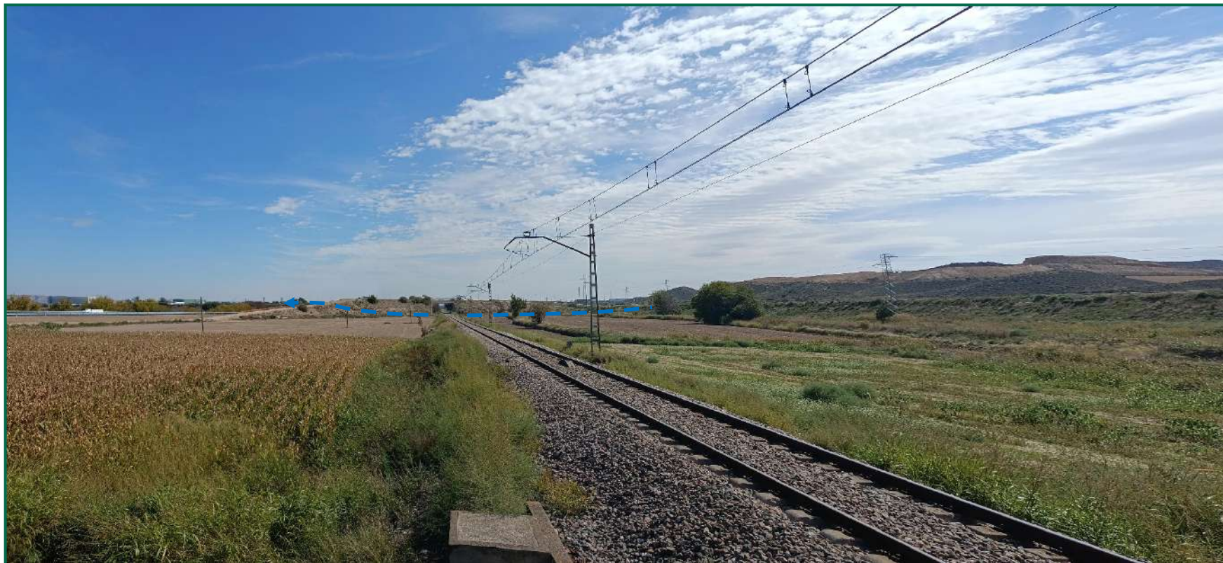
Fotografía 6. Recorrido de la línea de evacuación soterrada, cruce con vías de ferrocarril y con ramal de carretera.
