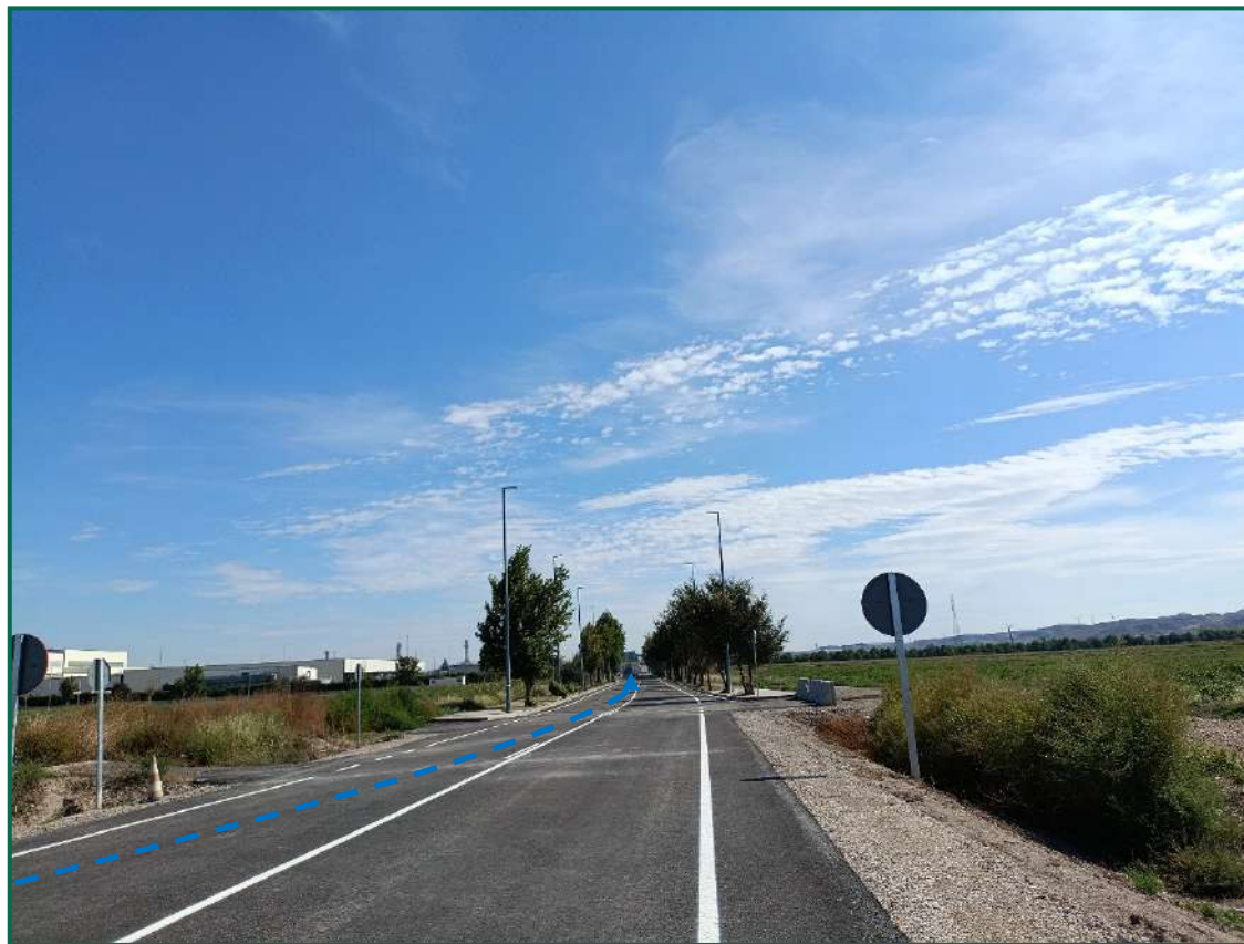
Fotografía 14. Recorrido de la línea de evacuación soterrada
