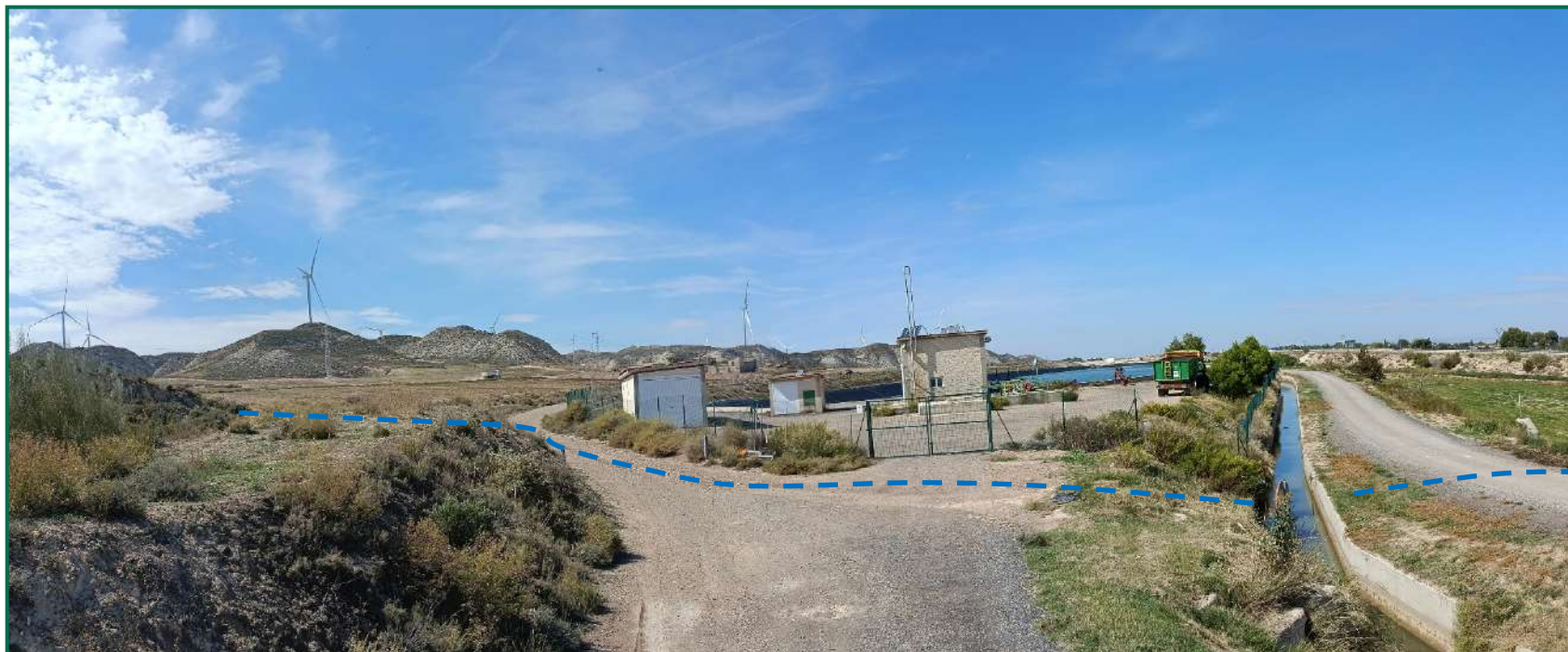
Fotografía 4. Recorrido de la línea de evacuación soterrada, cruce con el Canal Imperial de Aragón.
