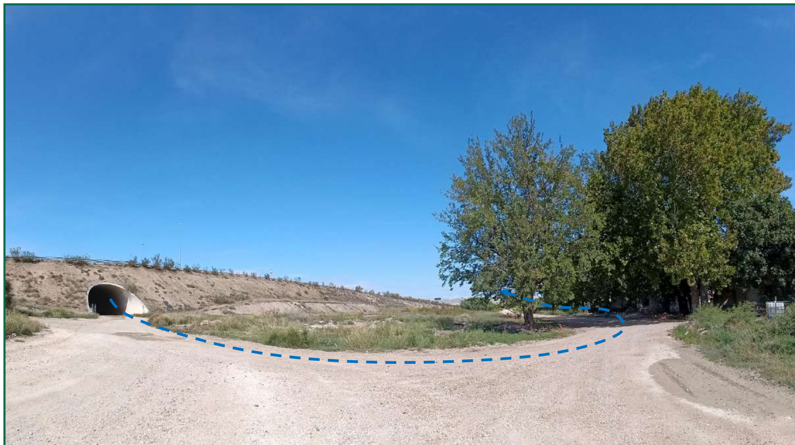
Fotografía 10. Recorrido de la línea de evacuación soterrada
